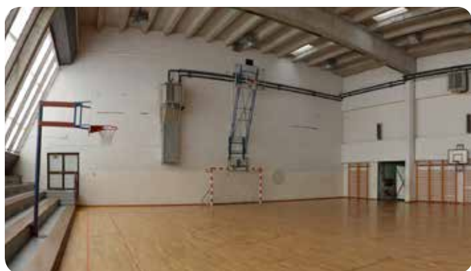
ŠOLSKA ŠPORTNA DVORANA NOVA GORICA, PRED PRENOVO
